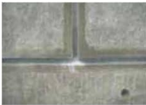
出隅・目地周りはコンク リートをよく充填させる。
