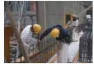
型枠の建て込み。 (打ち放し面の型枠精度が必要)
