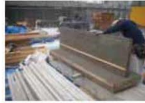
目地棒、セパ等を設置 する。
