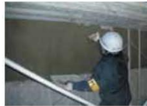
タイルモルタルは2度塗 り施工で繊維に食い込ま せる。
