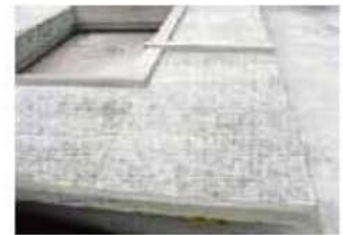
PC板への打ち込み工法 も有効。
