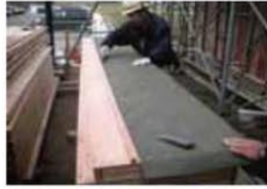
型枠への設置。 タイル張付け面(白い繊維面) を型枠に伏せタッカーで 止め付ける。
