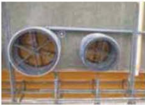
スリーブ形状にあわせて ウェブフォームを切り抜き 設置する。
