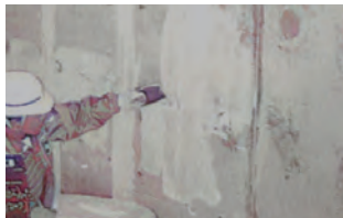
断面修復・不陸調整
