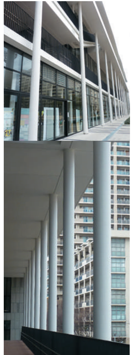
現 場 名 大阪市城東区役所複合施設 設 計 大阪市都市整備局 株式会社 日建設計 建設会社 浅沼・中林特定建設工事共同企業体
