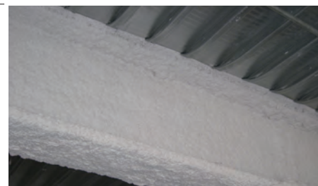
内部吹付仕上げ
