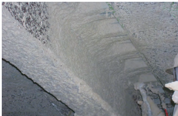
施工例 吹付け
