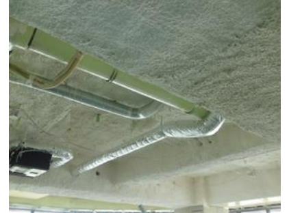
コンクリートスラブ下
