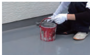
防水材施工後3h(27°C)で上塗り塗装実施
