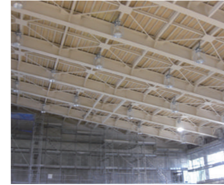
体育館 鉄骨梁
