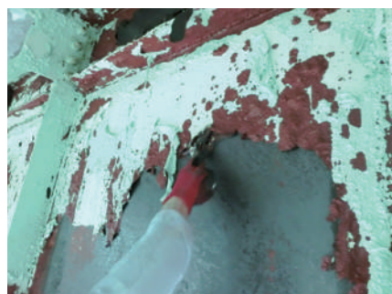
スクレーパーによる剥離作業
