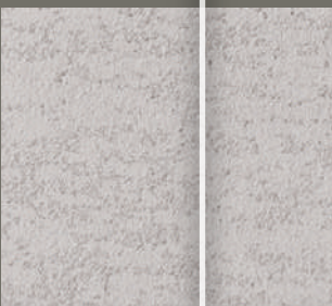
[バレアル] 吹付け+ 角コテ押え
