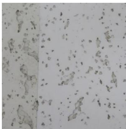
岩綿吸音板の上に塗装
