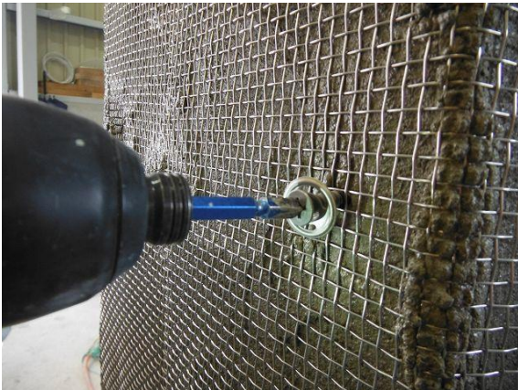
アンカーピンの取り付け
