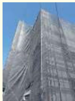
と そう げん ば ▲塗装の現場
