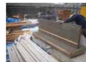
目地棒、セパ等を設置する
