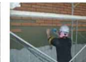
振動工具使用が有効 (繊維への喰い込み増)
