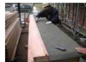
型枠への設置。白い繊維面を型枠面に伏せタッカーで止め付ける
