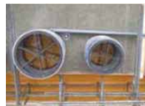
スリーブ位置にハサミでウェブを切り抜き設置
