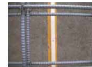
ひび割れ誘発目地部、出入り隅等はウェブフォームを透かす
